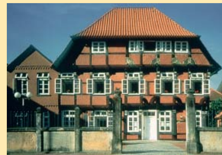
Posthof (sowie vor der Sanierung 1974)
